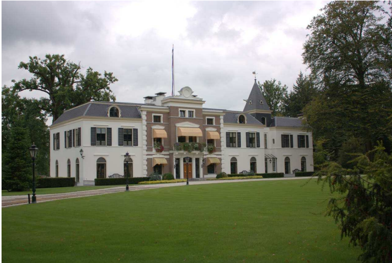
Afbeelding – Huidige situatie buitenplaats Den Treek (2015)
