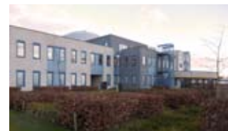
Bestaande bebouwing Groene zoom
