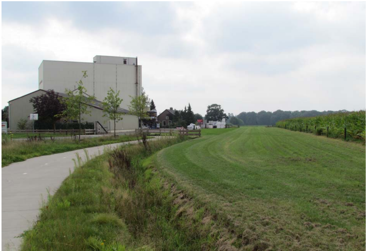
Beeld van het perceel waar de bouw van de nieuwe bedrijfshal is voorzien met links het veevoederbedrijf, rechts een maisakker en op de voorgrond het recent aangelegde vrijliggende fietspad
