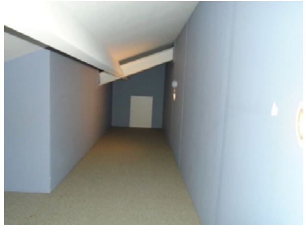
strak afgetimmerde zolder van aanbouw
