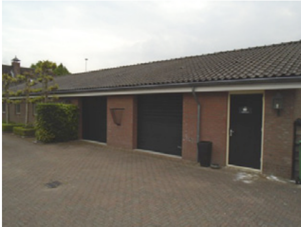
te slopen aanbouw zonder vogelschroot en open stootvoegen
