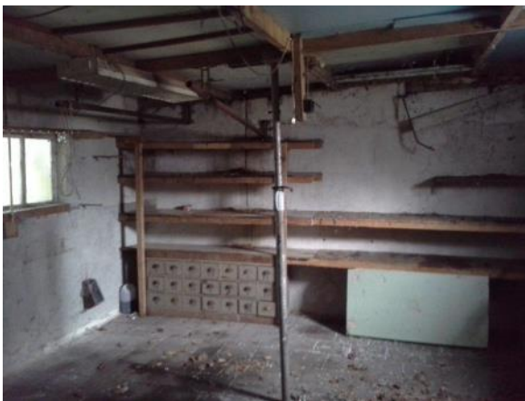
Foto 4: Schuur met sporen olie op vloer
