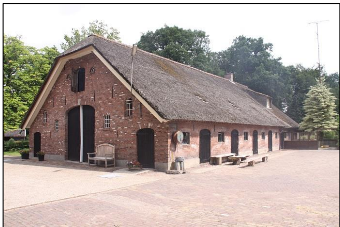
FIGUUR 8: ACHTERGEVEL VAN HET RIJKSMONUMENT, SITUATIE JUNI 2013
