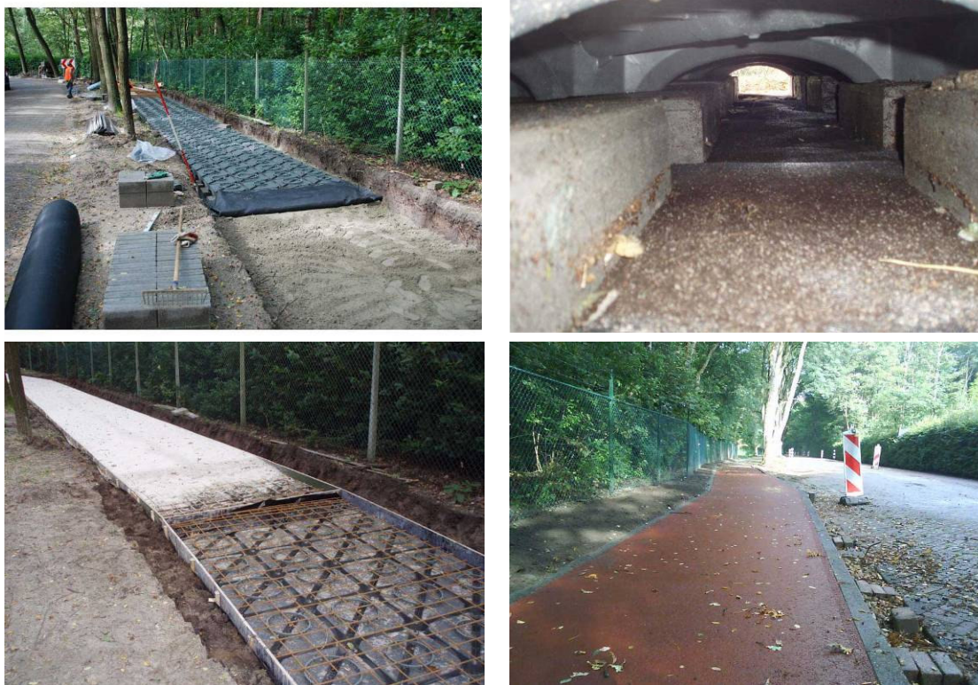
Voorbeeld 'wortelbrug', realisatie 2 e maaiveld (bron: www.waterblock.nl )
