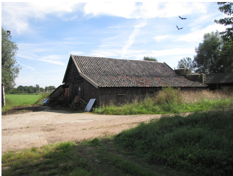
Figuur 3. Houten schuur met dakpannen en zonder dakbeshot.
