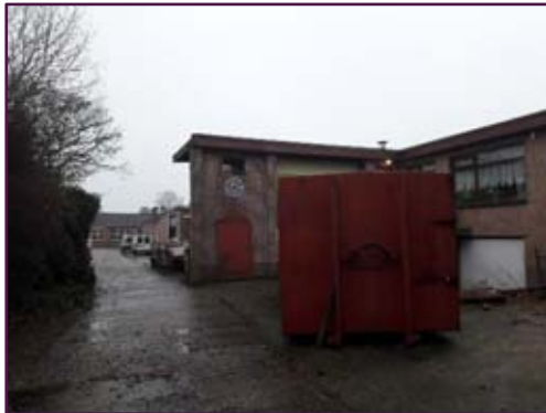
Figuur 2.4: aanzicht vanaf oprit
