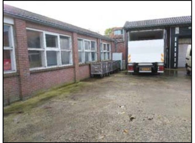
Foto 2: Betonverharding naast slagerij
