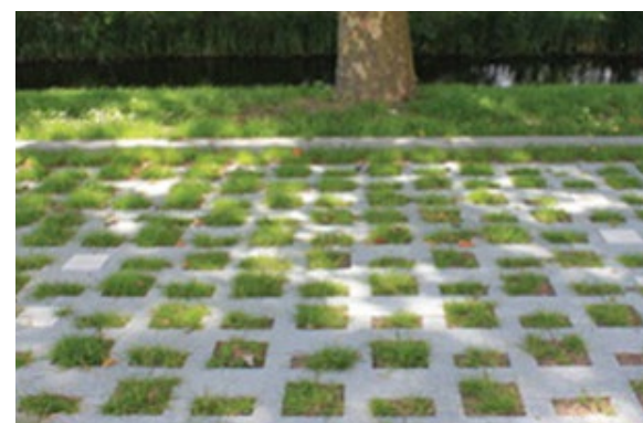
Referentie parkeren op grasbetonstenen
