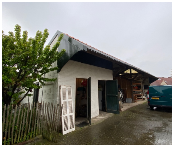
Figuur 3: schuur 1, wordt gesloopt ten behoeve van nieuwbouw.
