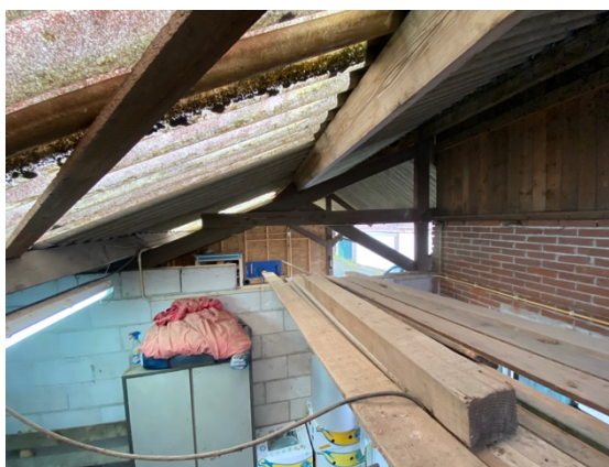
Figuur 8: Dak en houten balken binnenkant schuur 1.
