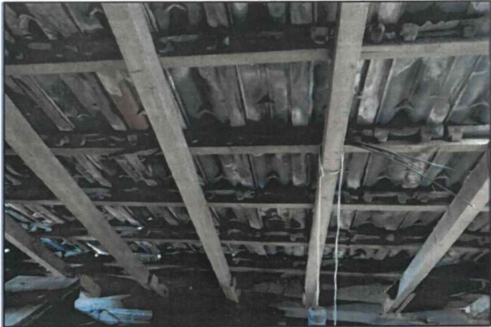
Figuur 1 De dakpannen op de schuren en de woning hebben niet een vorm die nestlocaties van de huismus toelaat. Daarnaast beschikken de schuren niet over dakbeschoot.
