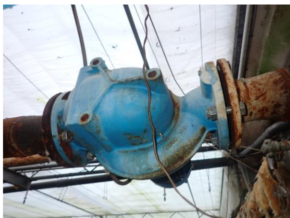
pompen met rubberen pakkingen
