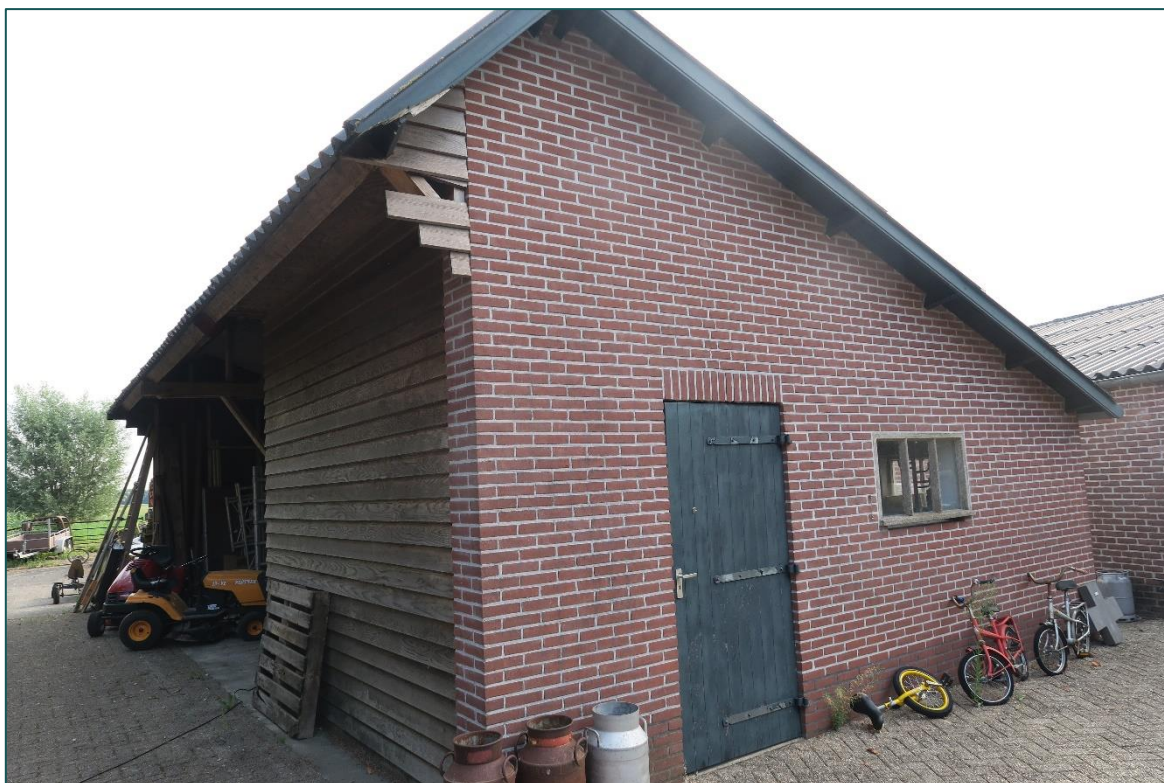
Figuur 2 Schuur 1 bestaat uit een kapschuur en een afgesloten deel.
