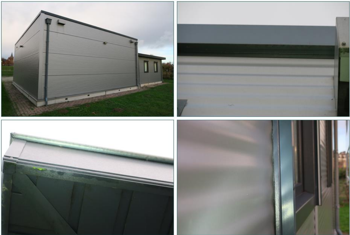
Figuur 3.1 De tijdelijke ambulancepost bevat geen geschikte invliegopeningen voor vleermuizen. De metalen platen sluiten strak op elkaar zijn, de daklijst sluit strak op de bebouwing aan en ruimten lang deur- en raamkozijnen zijn opgevuld.
