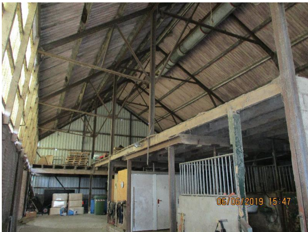
Figuur 2 In de meest noordelijk gelegen schuur, welke is opgetrokken uit metalen damwandplaten en golfplaten (asbest), zijn momenteel ponystallen gesitueerd en is wat materiaal opgeslagen.
