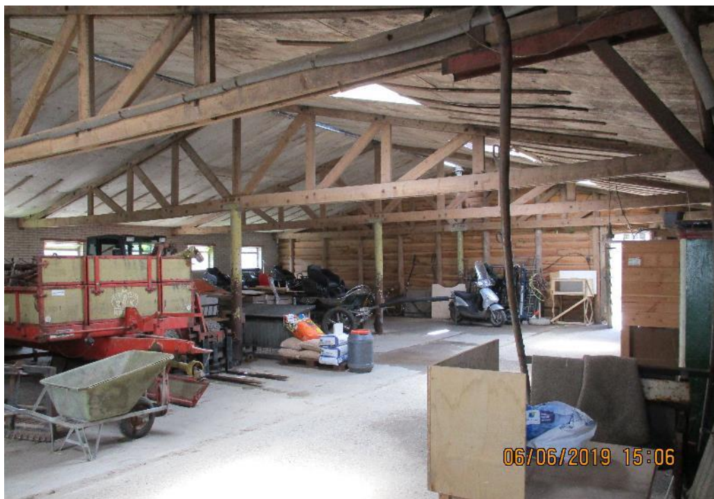
Figuur 3 De schuur die direct achter de boerderij is gelegen is opgetrokken uit bakstenen, houten planken en balken, een golfplaten dak (asbest) en houten damwandplaten. Het voorste gedeelte van deze schuur zal in de beoogde ontwikkelingen behouden blijven; het achterste gedeelte zal worden gesaneerd. De schuur functioneert momenteel als opslag voor voertuigen, materiaal en dierenhokken.
