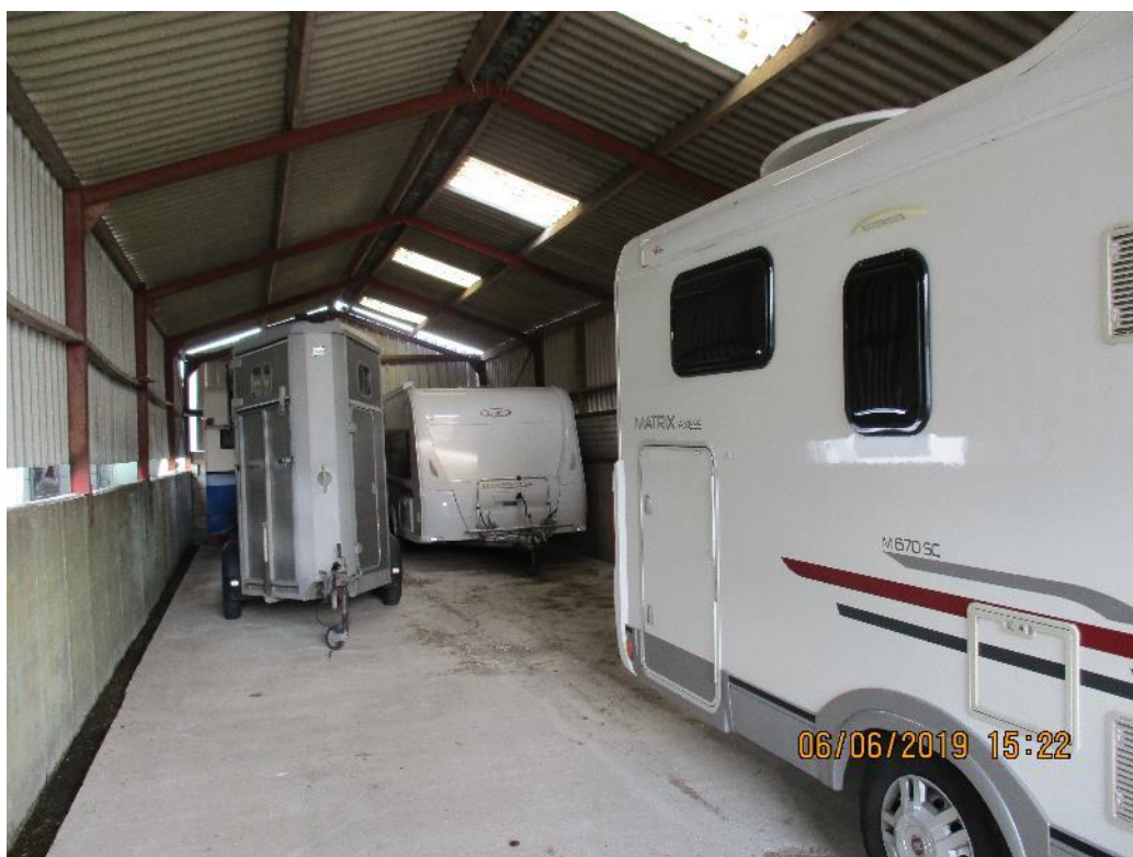
Figuur 6 Achter op het terrein is een open schuur gesitueerd welke is opgetrokken uit beton, metalen damwandplaten en een golfplaten dak (asbest). Ook deze schuur functioneert als opslag voor kampeervoertuigen.
