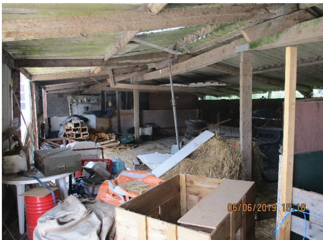
Figuur 4 In de smalle schuur die aan de ponyschuur verbonden is zijn tevens ponystallen aanwezig. De schuur is opgetrokken uit betonnen blokken en golfplaten (asbest), er is een betonnen vloer aanwezig.
