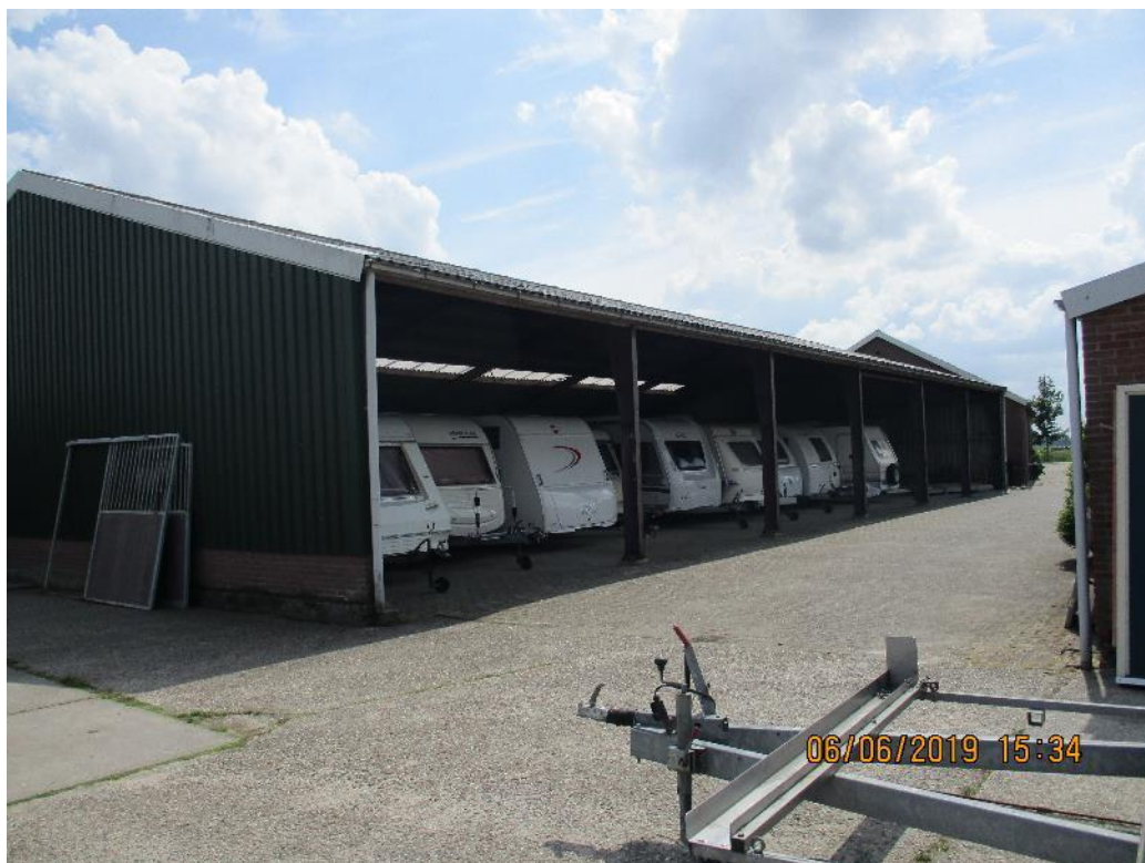
Figuur 5 De grote schuur naast de huidige rijbak is opgetrokken uit metalen damwandplaten en golfplaten (asbest) dakplaten, en functioneert momenteel als opslaglocatie voor caravans.
