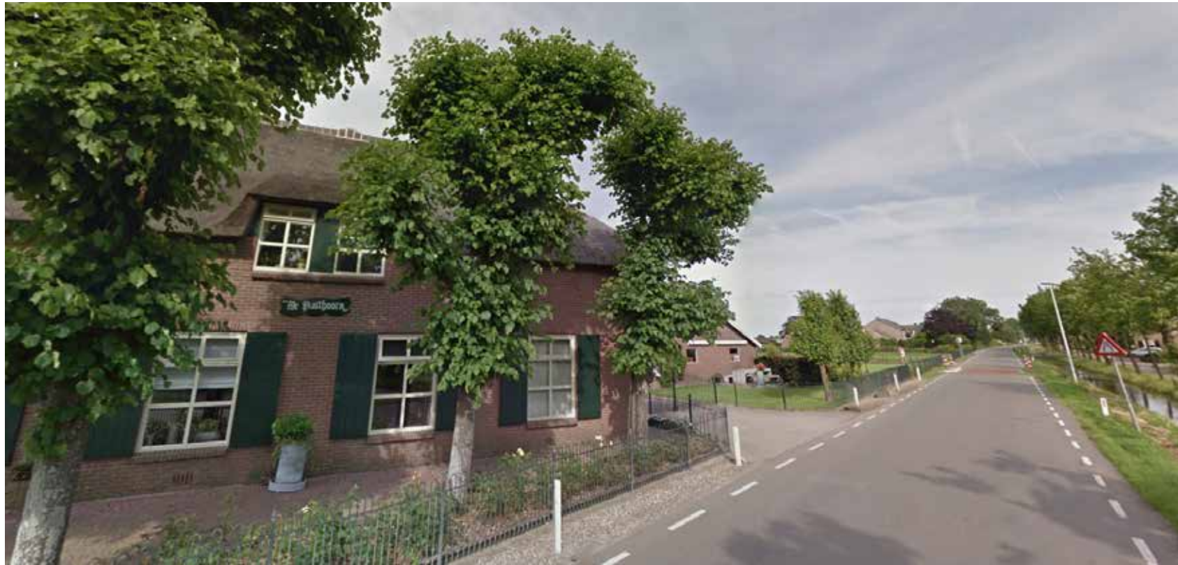
Hoofdbebouwing nr. 57 en 58
