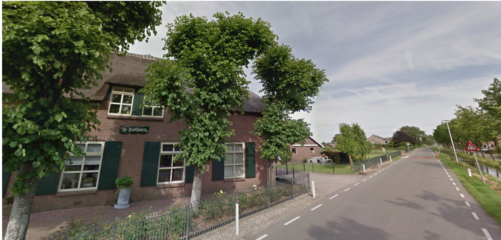
Hoofdbebouwing nr. 57 en 58
