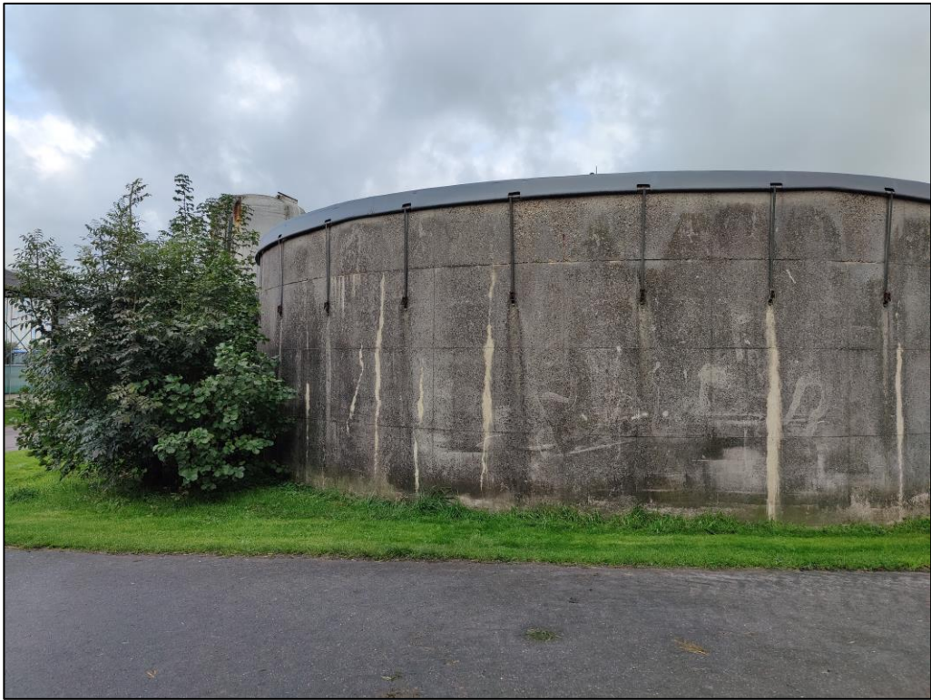
Figuur 3 De mestsilo gesitueerd op de planlocatie.
