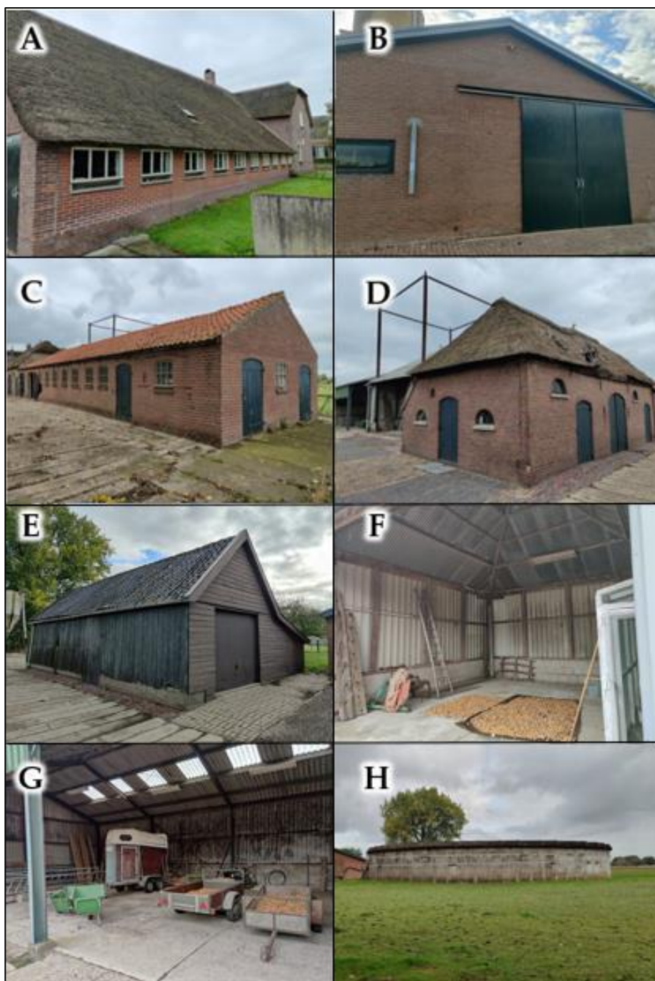
Figuur 3 Fotografische weergave van de bedrijfswoning met aangebouwde schuur(A), koeienstal(B), hooimijt(F), meststilo(H) en 4 schuren(C,D,E,G) op de planlocatie.
