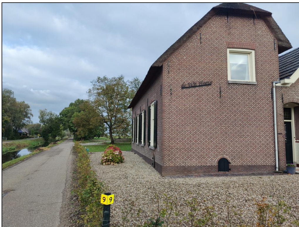
Figuur 1 De woning welke zich bevindt op de planlocatie gelegen aan de Kaaidijk 9 te Schalkwijk.
