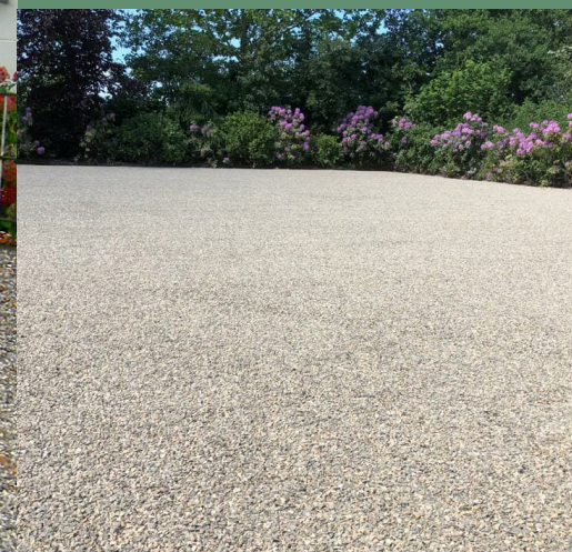
Referentiebeeld asfalt met lichte deklaag
