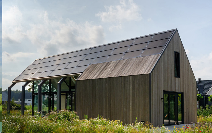
Referentiebeeld houten gevel
