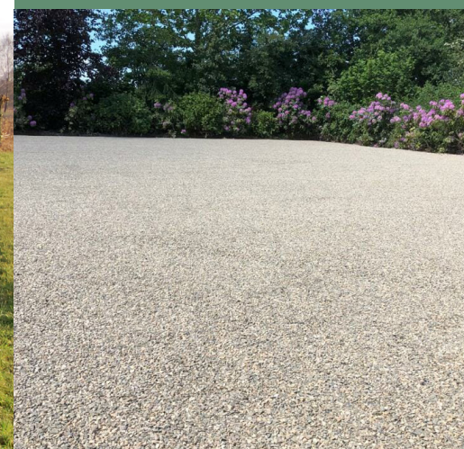
Referentiebeeld asfalt met lichte deklaag
