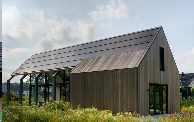
Referentiebeeld houten gevel
