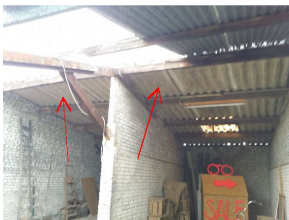
golfplaten dak garage
