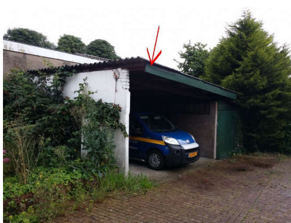
golfplaten dak schuur
