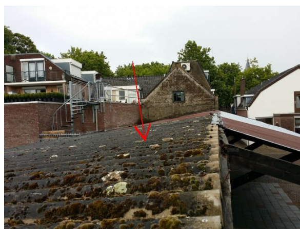
golfplaten dak garage
