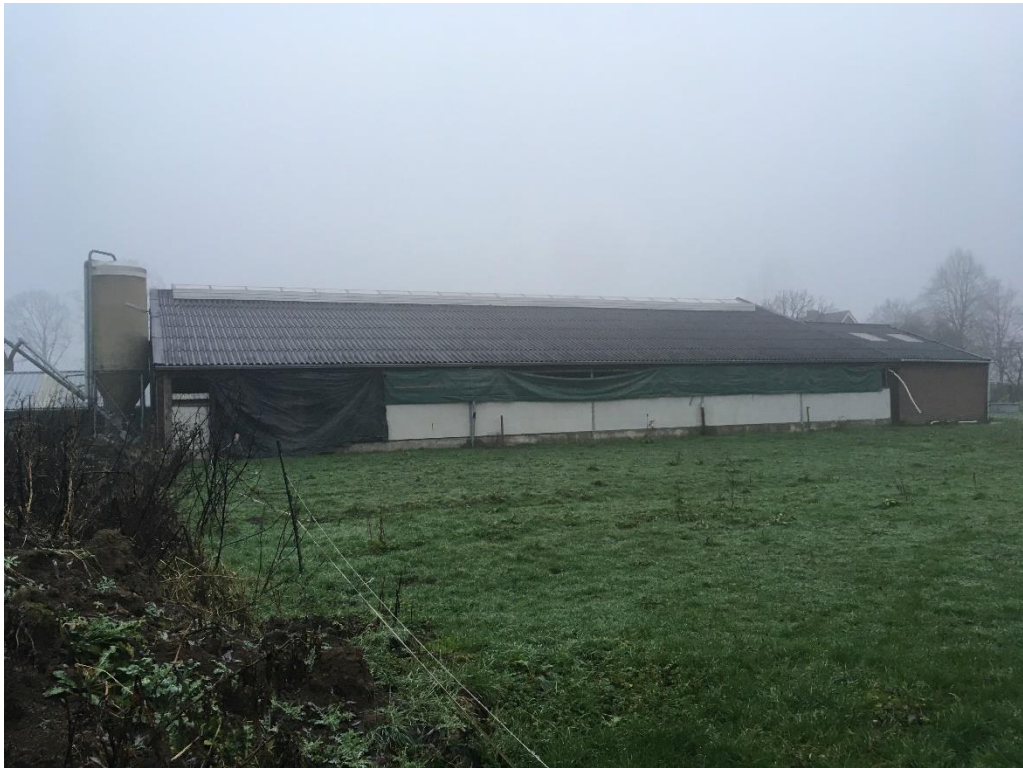
Figuur 3 Ten behoeve van de ontwikkeling dienen de bestaande opstallen te worden gesaneerd.
