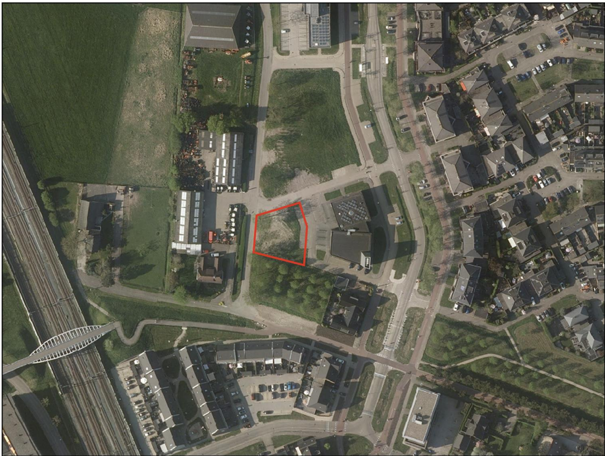
Afbeelding 2.1 Luchtfoto huidige situatie plangebied (Bron: Provincie Utrecht)
