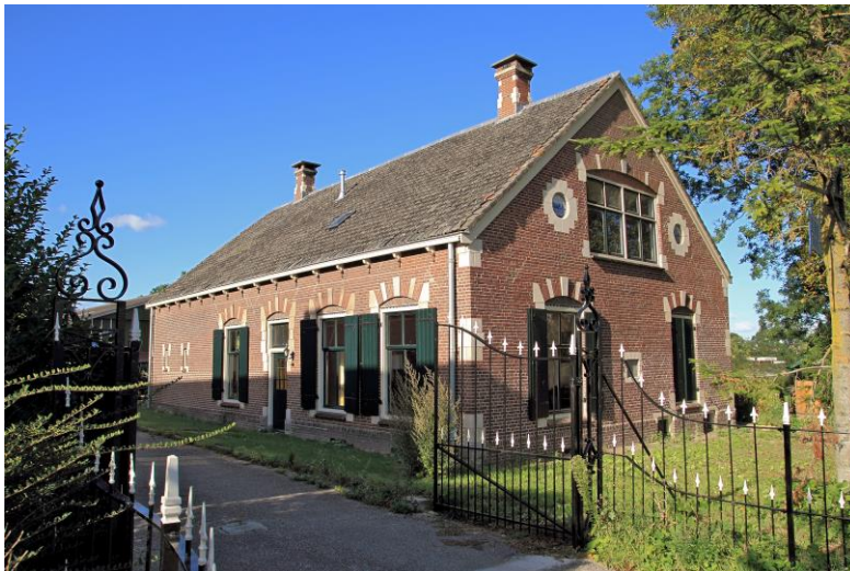
Zomerhuis uit 1898 aan de Hoge-weide 1a te Utrecht. De kleine woning is ten noordoosten van de boerderij gelegen, met de voorgevel naar de weg gekeerd. Het zomerhuis heeft een rechthoekige plattegrond en een zadeldak.
