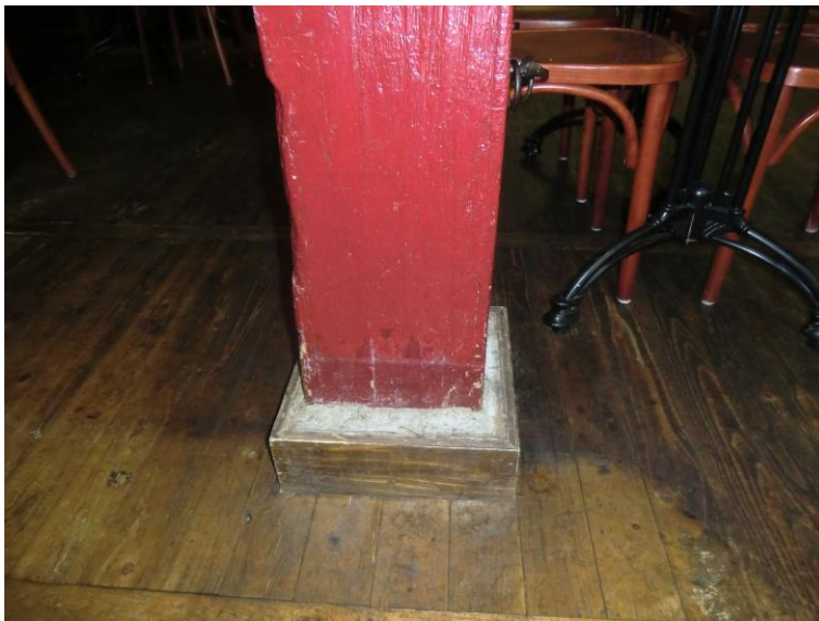
De gemetselde poeren zijn vervangen door nieuwe poeren van beton.
