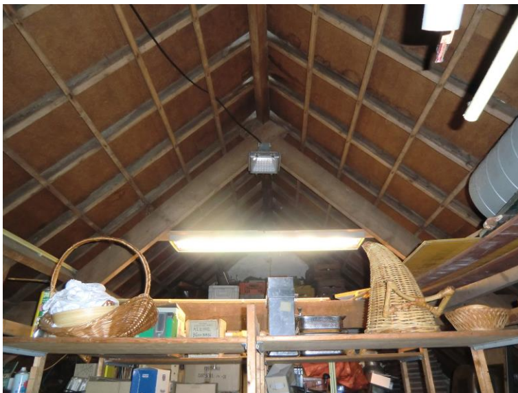
De zolder boven het grote cafégedeelte in het achterhuis. Deze zolder is de voormalige hooizolder en tegenwoordig in gebruik als opslag- / magazijnruimte.
