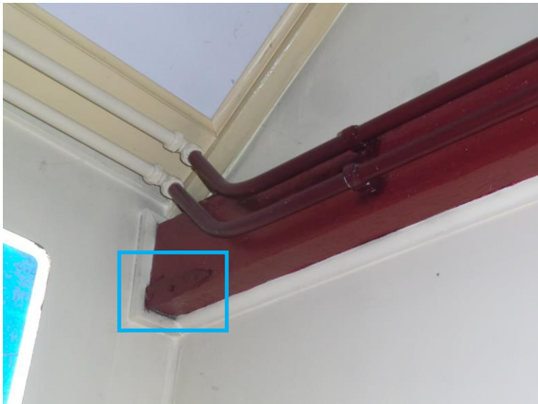
De dekbalken van de twee gebinten zijn met de hoge zijgevels verbonden door middel van muurankers. Aan de binnenzijde zijn de veren van deze ankers dan ook zichtbaar (blauw kader).
