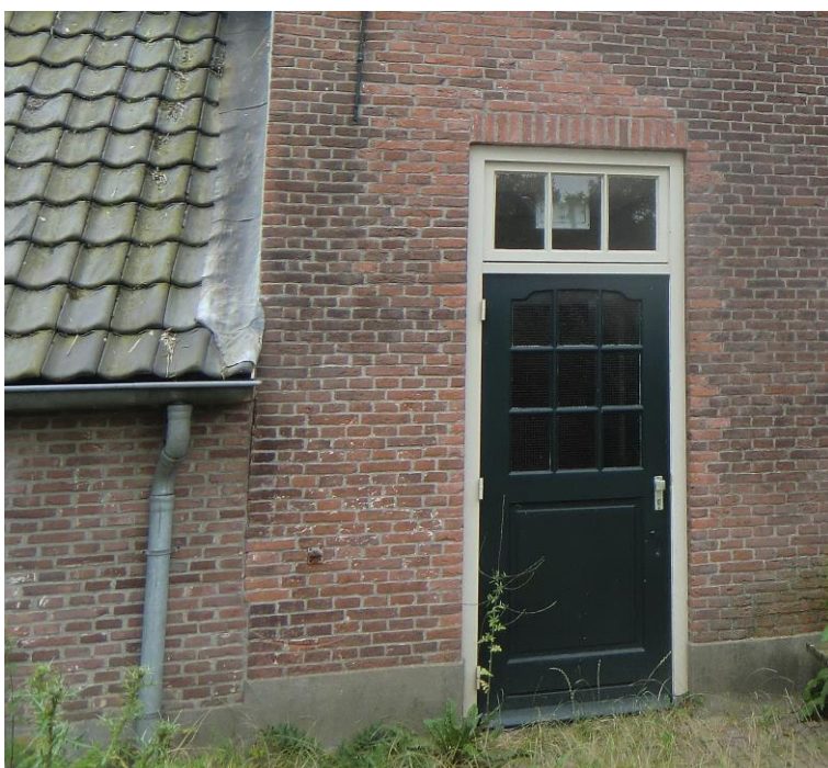
De nieuw toegevoegde toegangsdeur met bovenlicht op de plaats van een tweelichtvenster en een kelderraampje.
