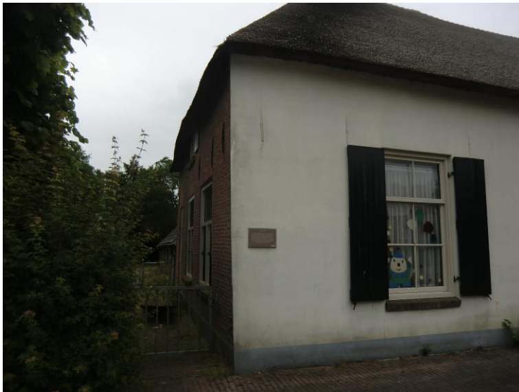
De voorgevel is gepleisterd, de linker zijgevel niet.
