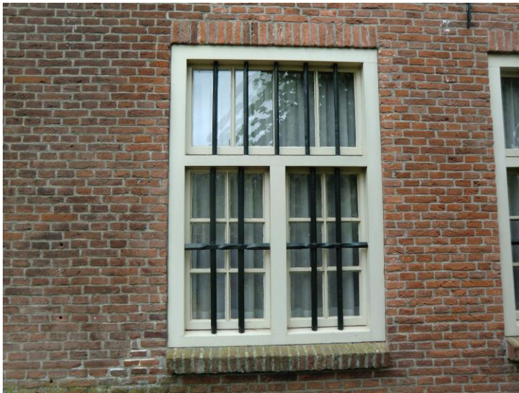
De bovenlichten van deze vensters hadden in de oorspronkelijke situatie geen diefsijzers. Mogelijk zijn hier de diefsijzers van de oude zolder- of kelderraamkozijnen hergebruikt en in de nieuwe kozijnen aan de bovenlichten toegevoegd.
