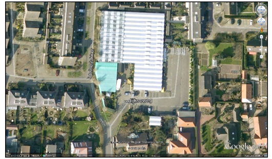
Google Earth Luchtfoto
