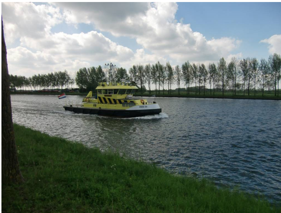
Afbeelding 14 - Het Amsterdam-Rijnkanaal, in de jaren 30 gegraven om de verbinding tussen Amsterdam en het Duitse achterland te verbeteren.
