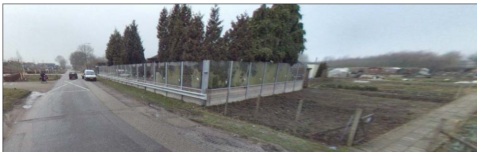
Figuur 4.3: Impressie van het aanwezige geluidsschermbaan langs De Brug
