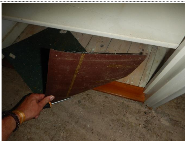
Geen asbestverdachte vloerafwerkingen
