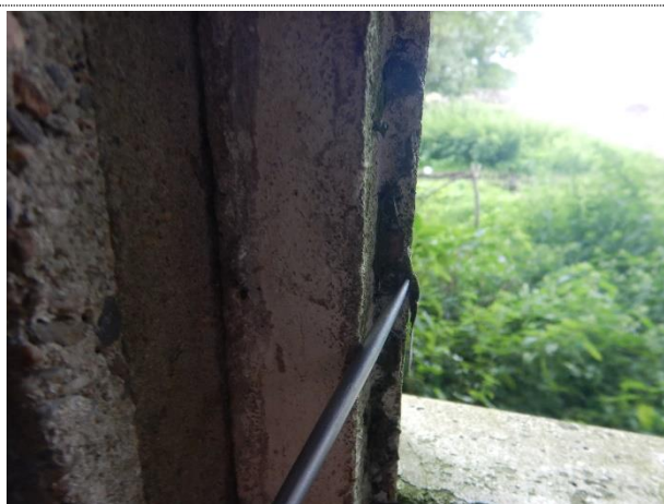
Siliconenkit bij kozijnen schuur 4
