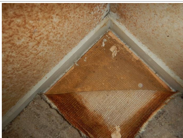
Geen asbestverdachte vloerafwerkingen
