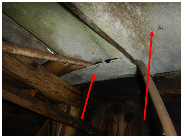
Plaatje gelijktijdig met golfplaten verwijderen
