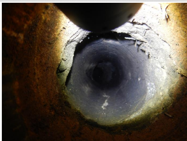
Cement getrokken rookgaskanaal
