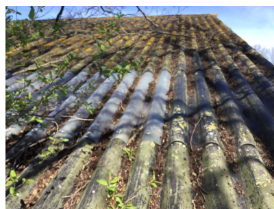
AC golfplaat (dak)
