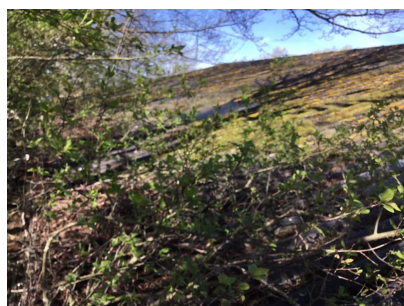
AC golfplaat (dak)
