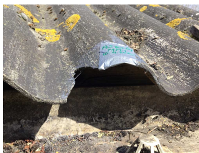
AC golfplaat (dak)
