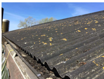
AC golfplaat (dak)
