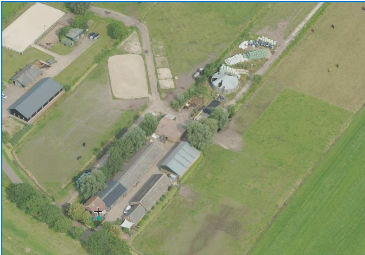
Figuur 1 Luchtfoto perceel Eemdijk 3 te Eemdijk (bron: Street Smart)
