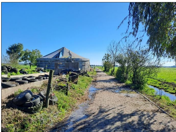
Foto: opgeslagen materialen en grondwal naast kuilvoerplaten.
