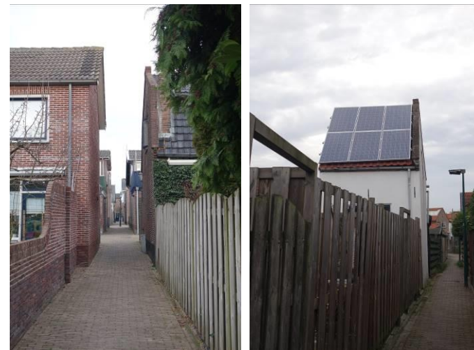
Complex woningen op de Nieuwe Schans. Rechts een bijgebouwtje op het achtererf van de kleine woningen.
