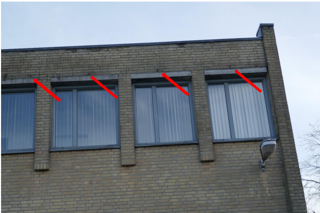
Foto 2: Het AH gebouw met open stootvoegen vormt in potentie een geschikte vaste rust- en verblijfplaats voor vleermuizen. Door het veranderende bouwplan blijven deze open stootvoegen beschikbaar. Effecten treden niet op omdat de nieuwbouw slechts eenlaags is en niet tot de bovenste delen uitgevoerd wordt.
