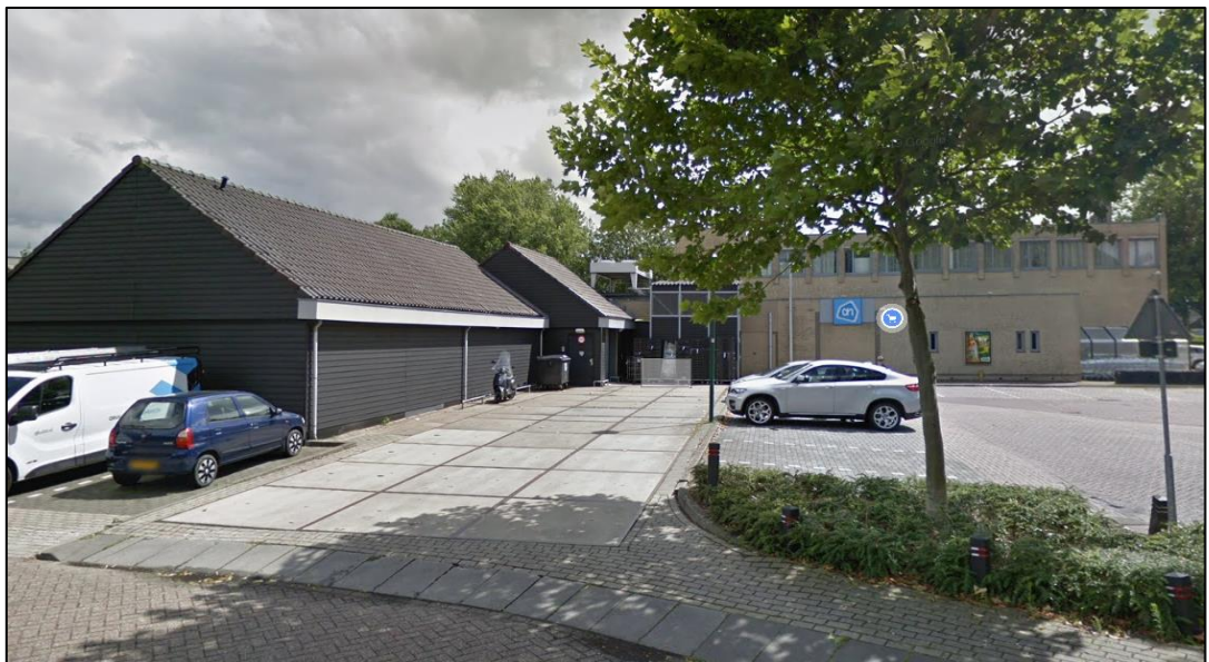
Los- en laadplaats aan de achterzijde van het gebouw.
