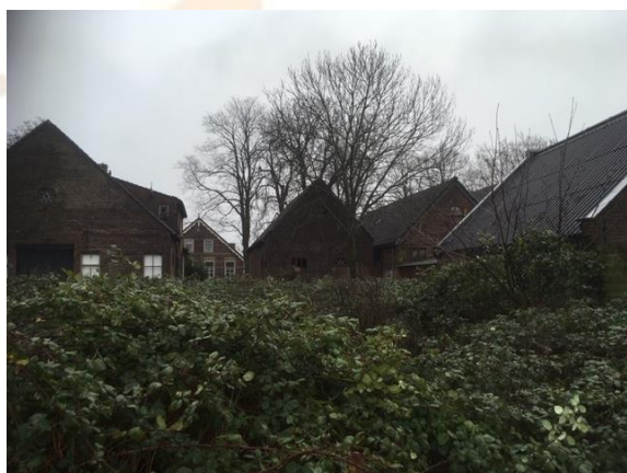
Figuur 3.0 vervallen woning buiten onderzoekslocatie (bron: F&F Solutions)
