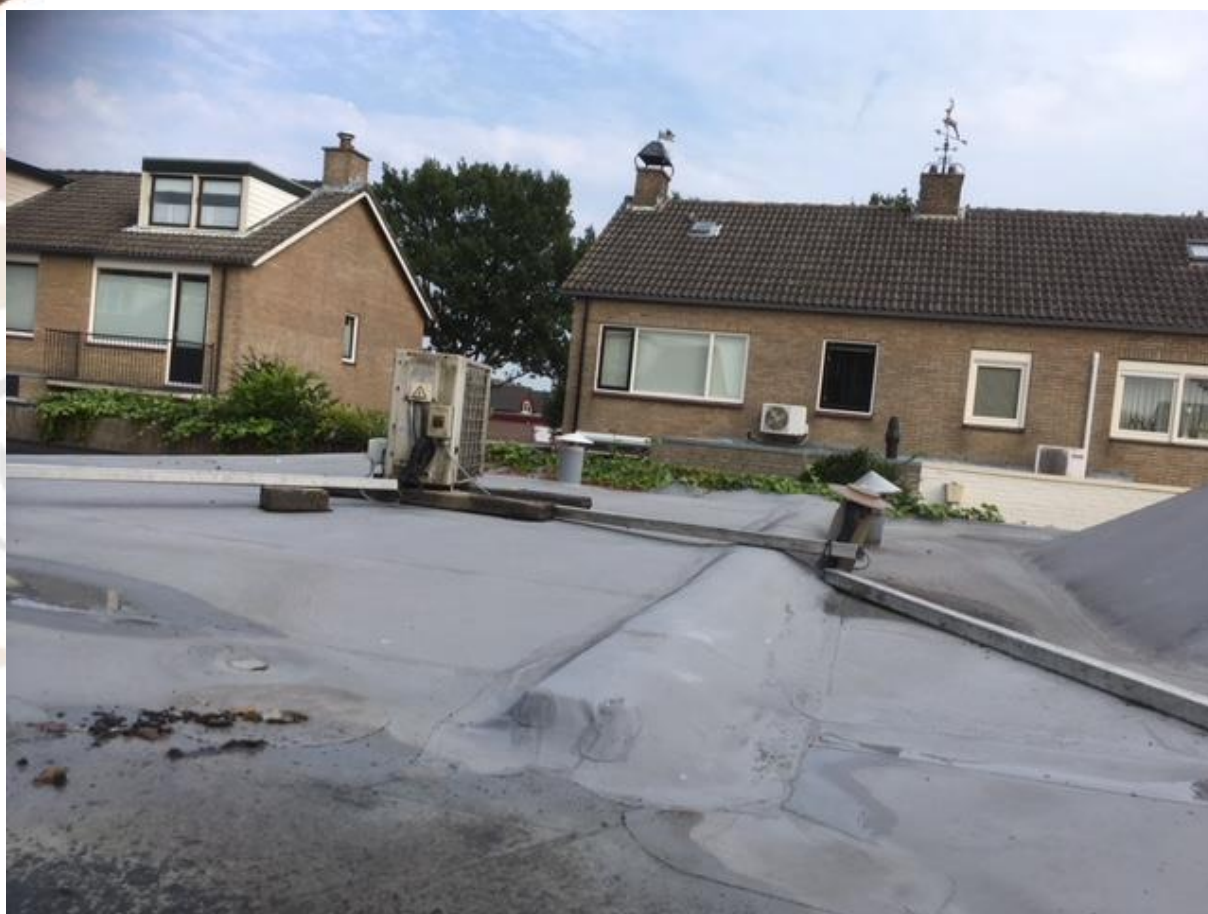
De dakontluchtingspunten bevatten geen sporen van beschermde soorten (Bron: FF Solutions)
