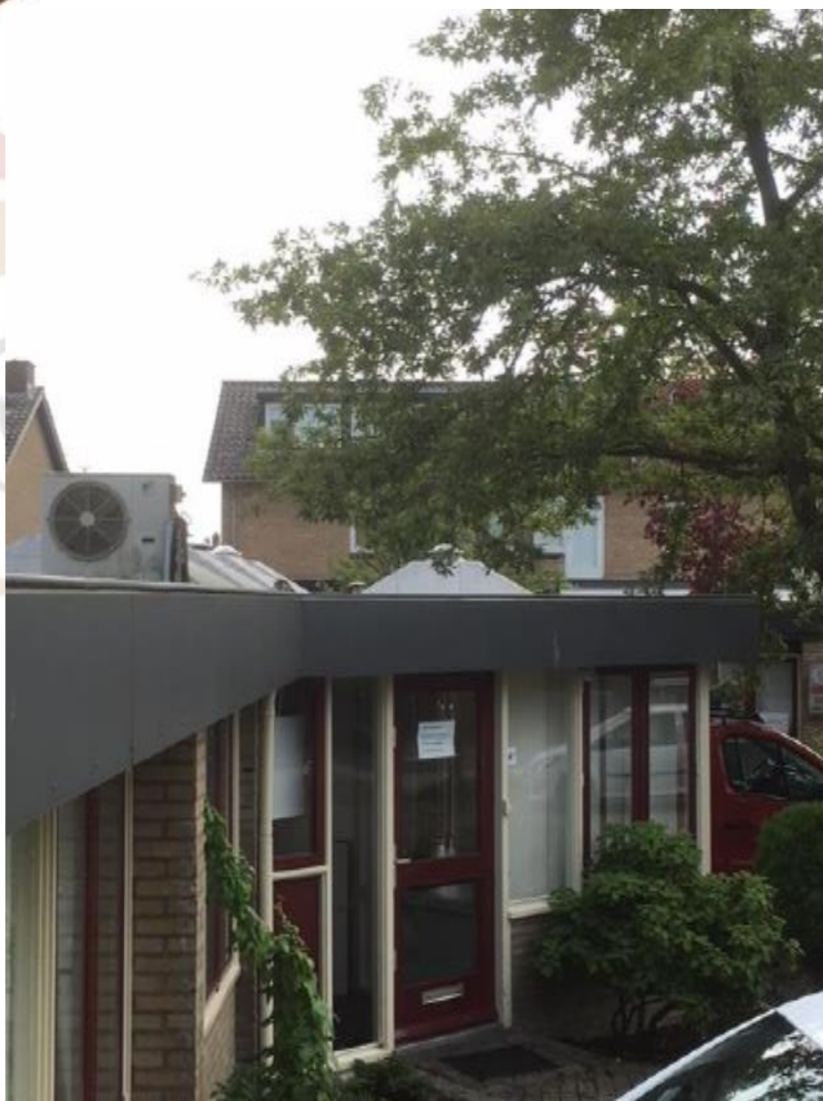
Het stenen gebouw is in goede staat van onderhoud en heeft veel ramen en een boeibord rondom (Bron: FF Solutions)
