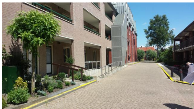
Figuur 17 huidig binnengebied t.p.v. ingang Op de Ree, links het woongebouw uit 1995.
