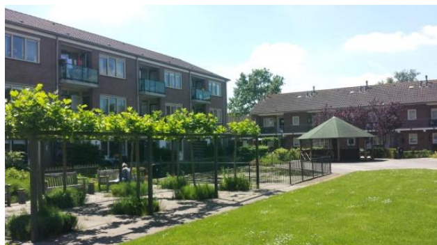
Figuur 20 huidig binnengebied; tuin voor de bewoners met links het woongebouw uit 1995, rechts een woongebouw uit 1960
