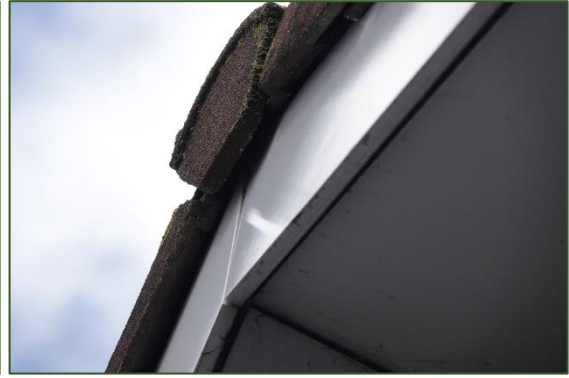
Fig. 2.2 Aansluiting nok met boeiboord (bron: FF Solutions)
