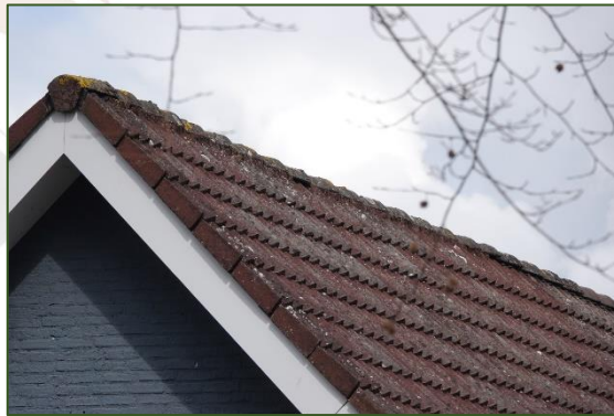
Fig. 2.3 Goed aansluitende dakpannen (bron: FF Solutions)
