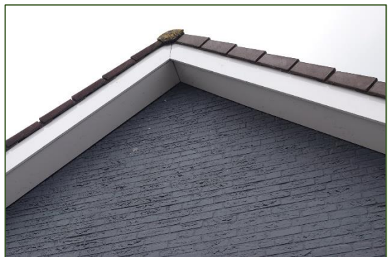
Fig. 1.4 Aansluiting boeideel met gevel (bron: Quicksan)
