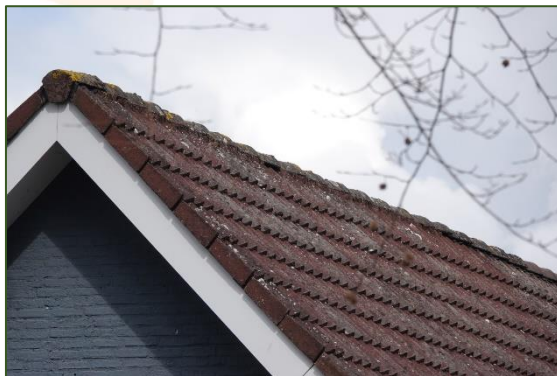
Fig. 1.3 Goed aansluitende dakpannen (bron: Quicksan)
