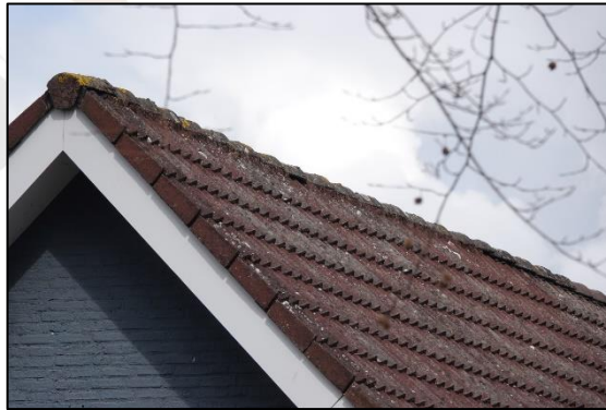
Fig. 2.5, Goed aansluitende dakpannen (bron: FF Solutions)
