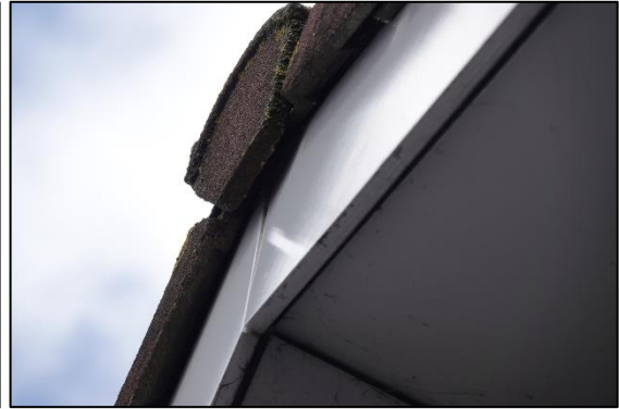
Fig. 2.4, Aansluiting nok met boeiboord (bron: FF Solutions)
