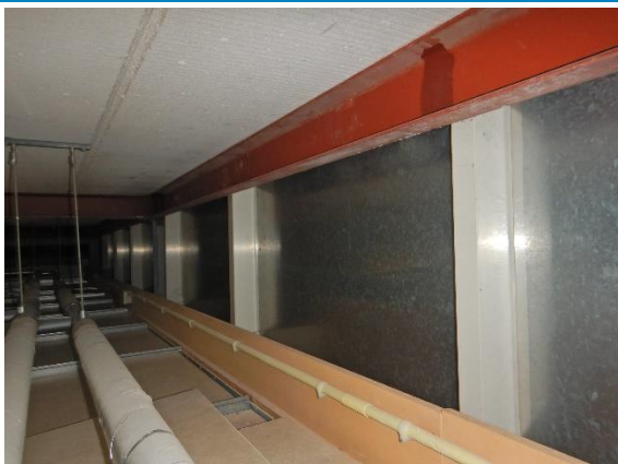
Staal in gevels
