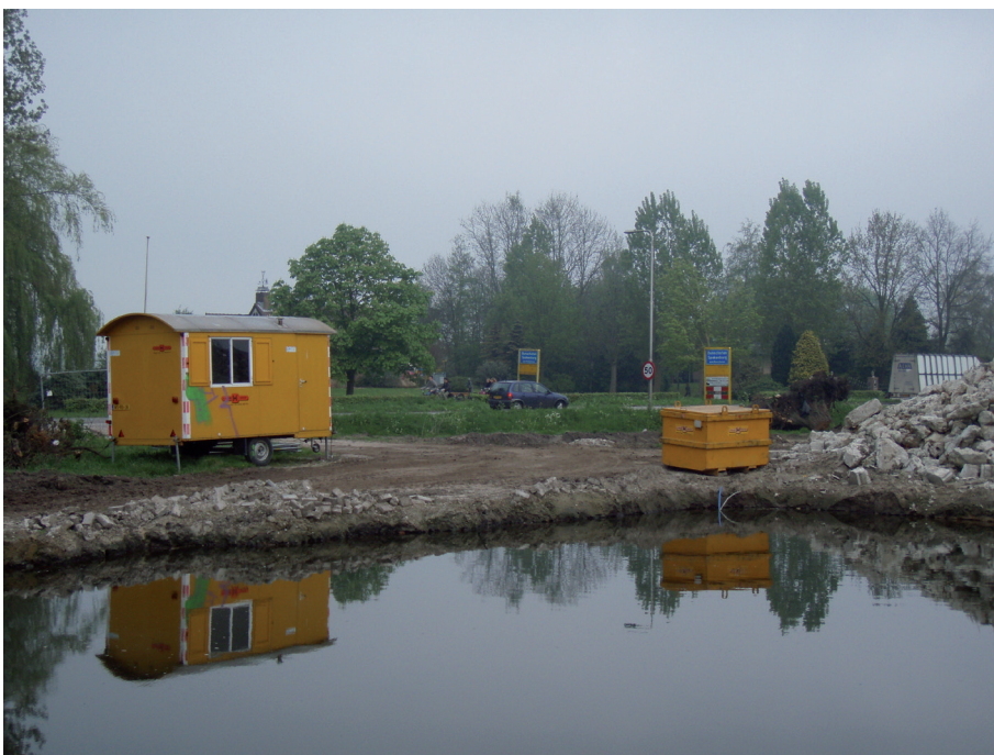
Afb. 5 Diepe kuilen waar de stallen hebben gestaan, met zicht op de Amersfoortseweg.
