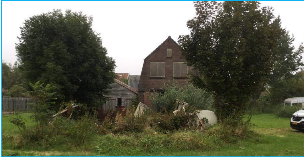
Foto 1: vervallen woning met slooppafval
