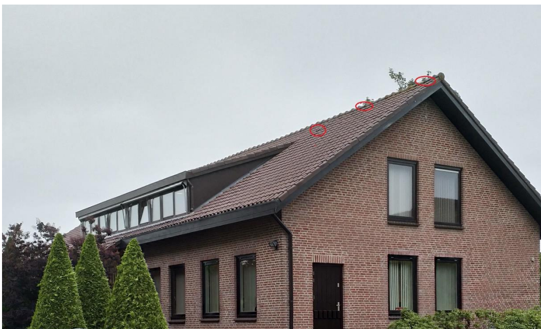
Afbeelding 6: Overzicht kantoorgebouw met mogelijke invliegopeningen vleermuizen (Laneco, 2021)
