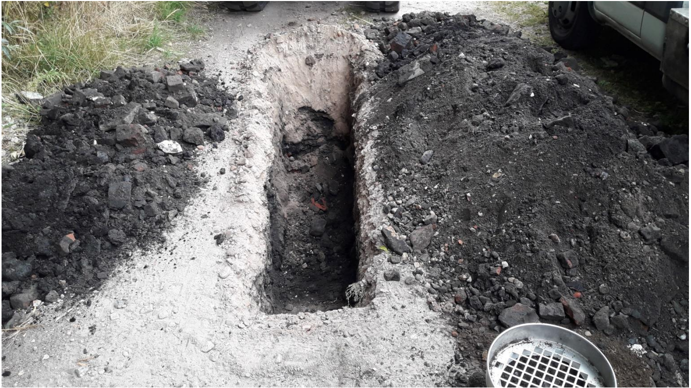
Foto 1: sleuf S102 door puinverharding
