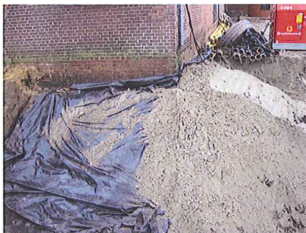
Ontgraving langs pand met restverontreiniging
