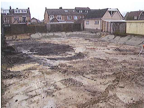
Overzicht ontgraving zuidwestzijde terrein
