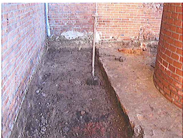
Situatie ontgraving bij schoorsteen
