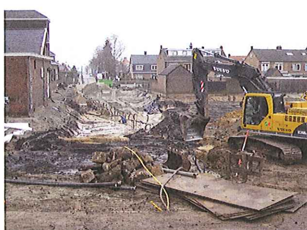
Overzicht ontgraving middenterrein
