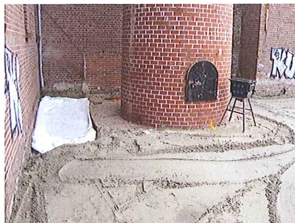
Situatie ontgraving bij schoorsteen
